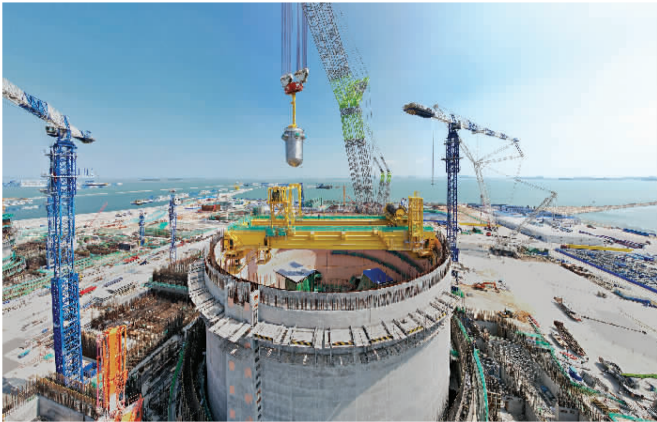
华龙一号漳州核电1号机组反应堆压力容器吊装
