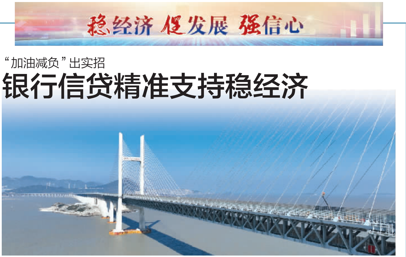
1月8日，在福建平潭公铁两用跨海大桥，福州工务段工作人员对大桥斜拉索作业(无人机照片)。 新华社图文
