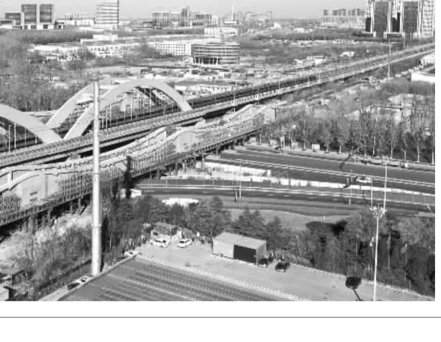
12月22日，中铁十局的工作人员在对济郑高铁跨济南经十西路槽型梁进行合龙作业（无人机照片）。
