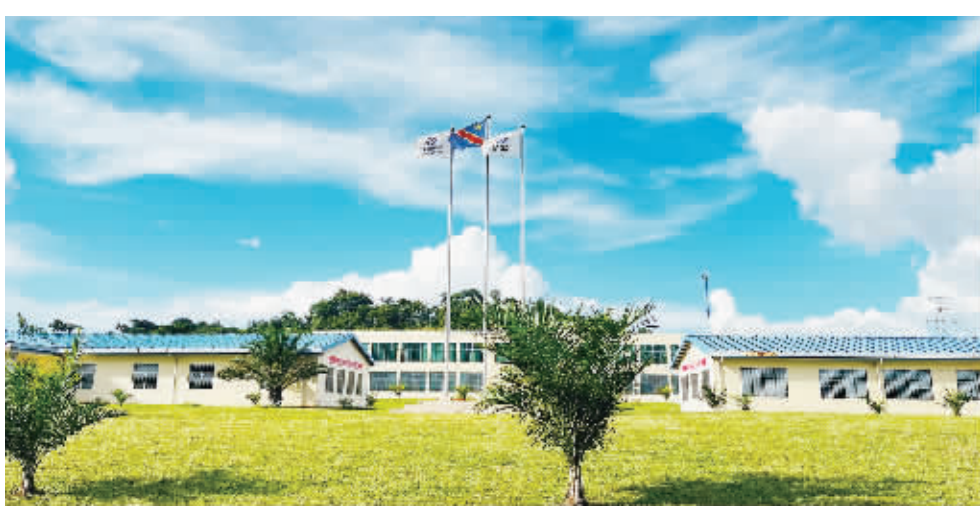
华友钴业非洲总部大楼
