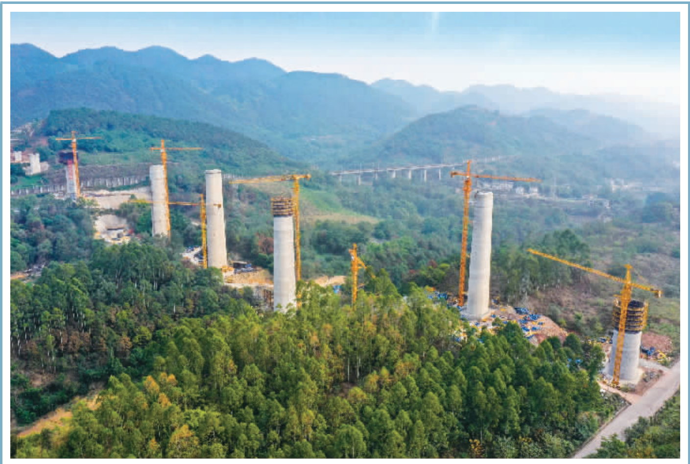
渝昆高铁川渝段加紧施工 这是11月28日拍摄的渝昆高铁川渝段华福特大桥施工作业现场(无人机照片)。日前,由中铁十一局承建的渝(重庆)昆(昆明)高铁川渝段站前一标项目正加紧施工,工程进度稳步推进。渝昆高铁全长699公里,设计时速350公里,是全国高铁网“八纵八横”之一京昆通道的重要组成部分。 新华社图文
