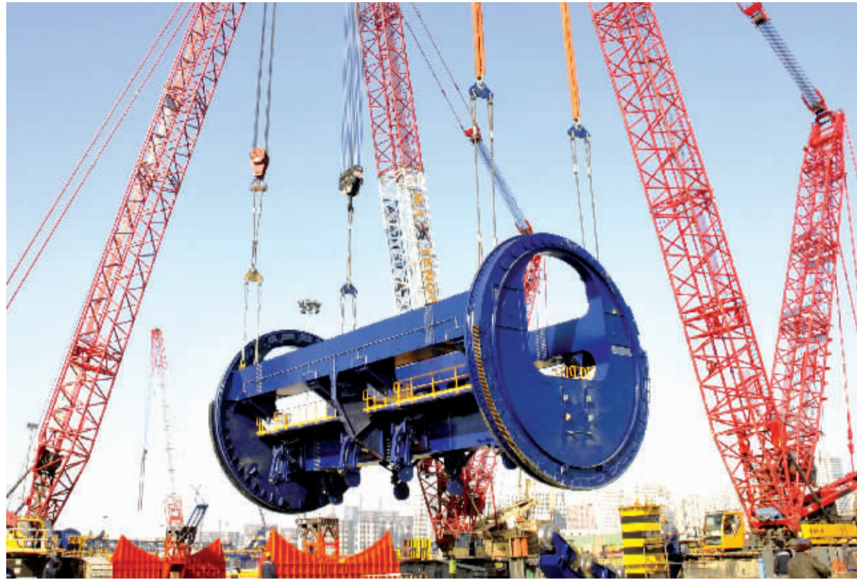
大连重工不解列贯通式FZ2-10双车翻车机吊装发运现场
