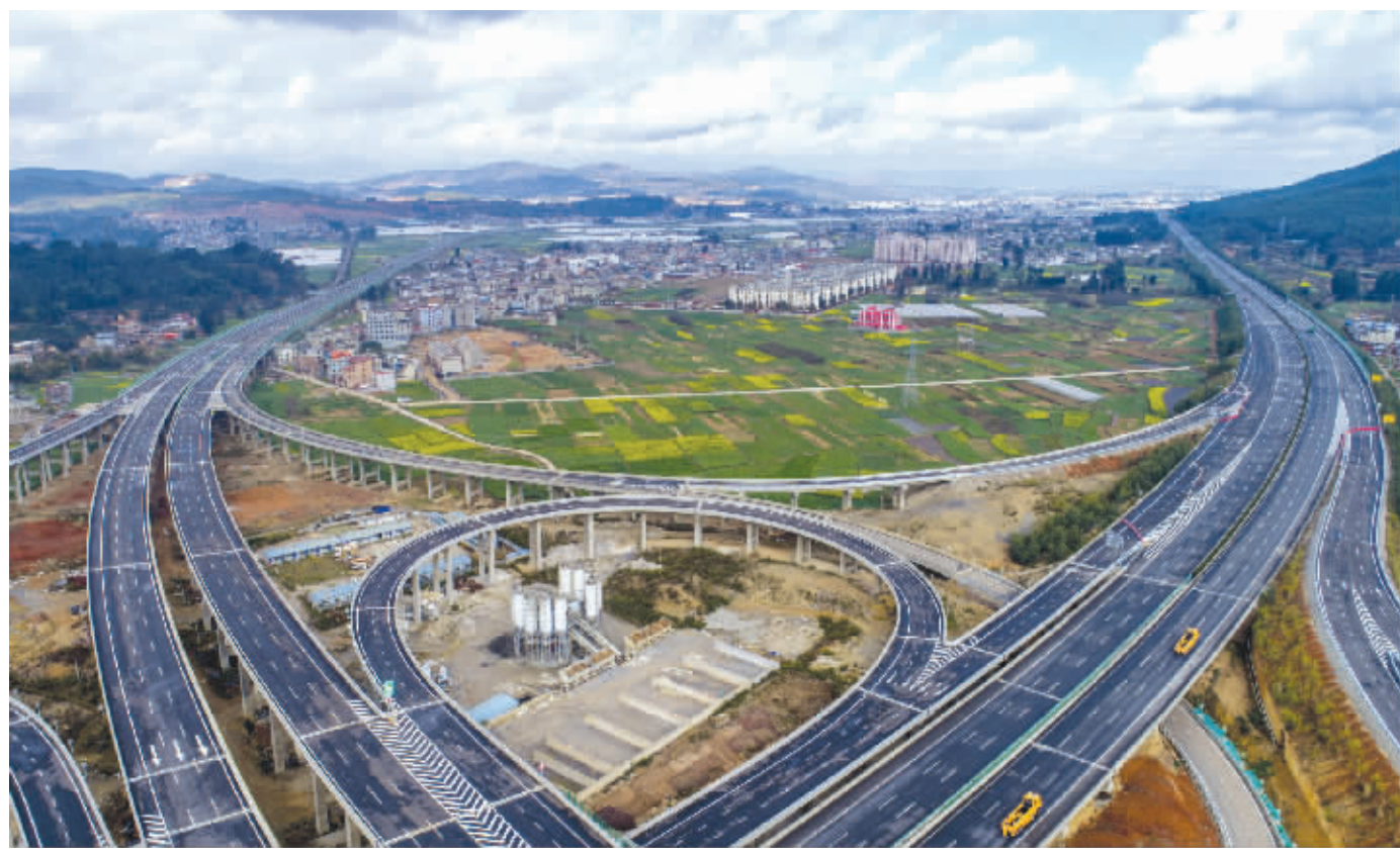
图为新昆楚高速公路（左）与武易高速公路（无人机照片）。新昆楚高速公路起于昆明市五华区岷山附近，止于楚雄州禄丰市广通镇，线路全长约106公里，桥隧比62.8%，按双向六车道高速公路标准建设，设计速度每小时100公里。 新华社图文
