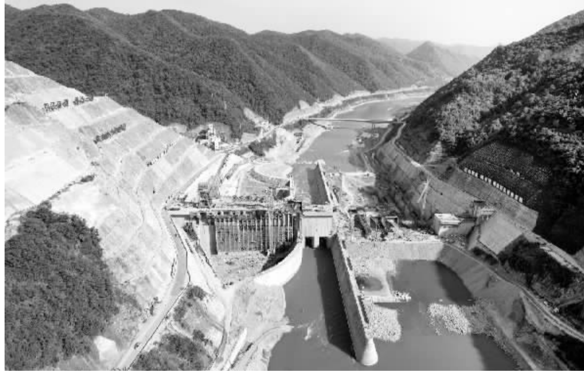
建设中的引汉济渭工程黄金峡水利枢纽。
