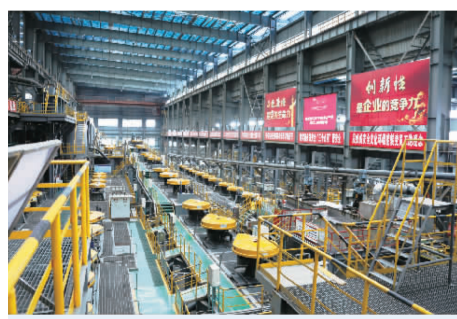
锡业股份华联锌铟8000吨选矿厂浮选平台
