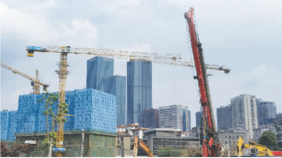
长沙万科臻湾汇项目工地
