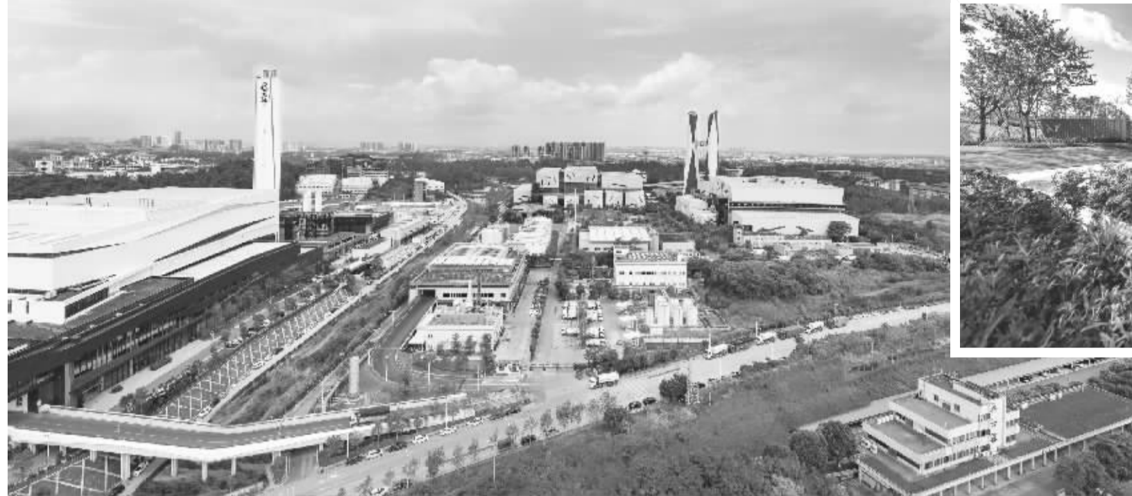
瀚蓝南海固废处理环保产业园
