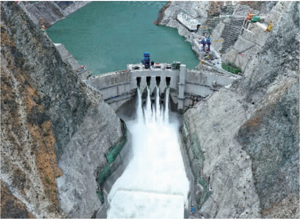
杨房沟水电站
