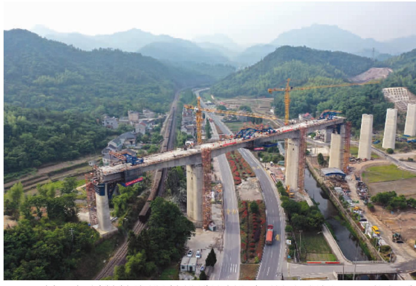
5月22日凌晨，位于浙江省建德市境内的杭衢铁路跨金千铁路特大桥连续梁主跨顺利合龙，为后续的架梁施工以及无砟轨道施工奠定基础。杭衢铁路正线全长约131公里，速度目标值每小时350公里，共设建德、建德南、龙游北、衢江、衢州西、江山6个车站，是长三角城际铁路网的重要组成部分。
