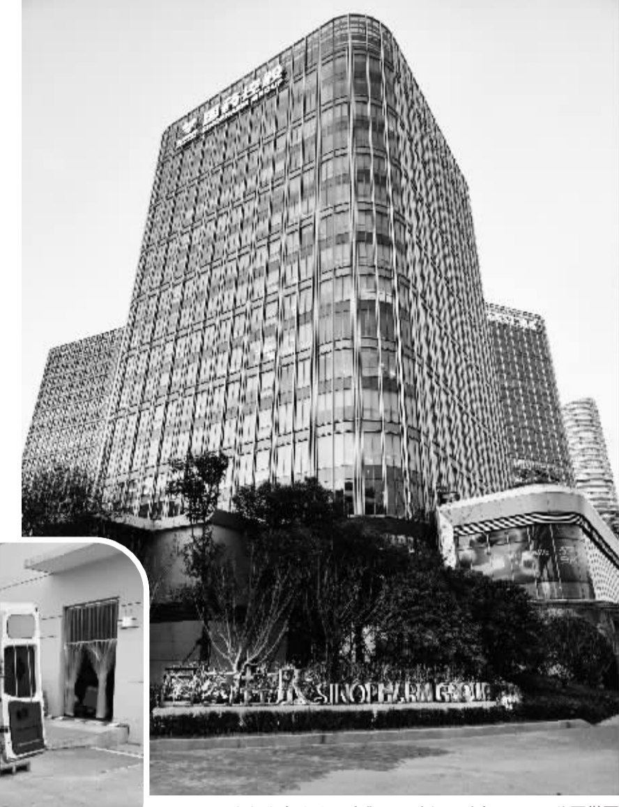
位于上海龙华东路的国药集团国药控股总部 公司供图
