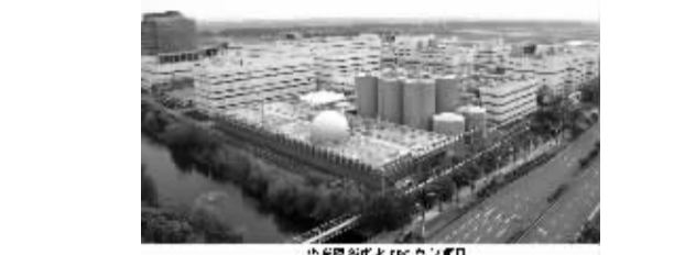
宁波市海曙区水质净化厂
