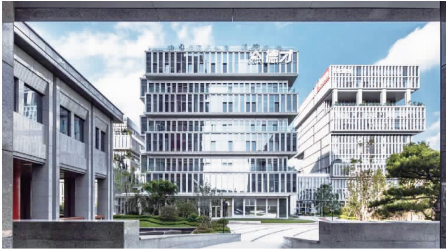
德才股份厂区
