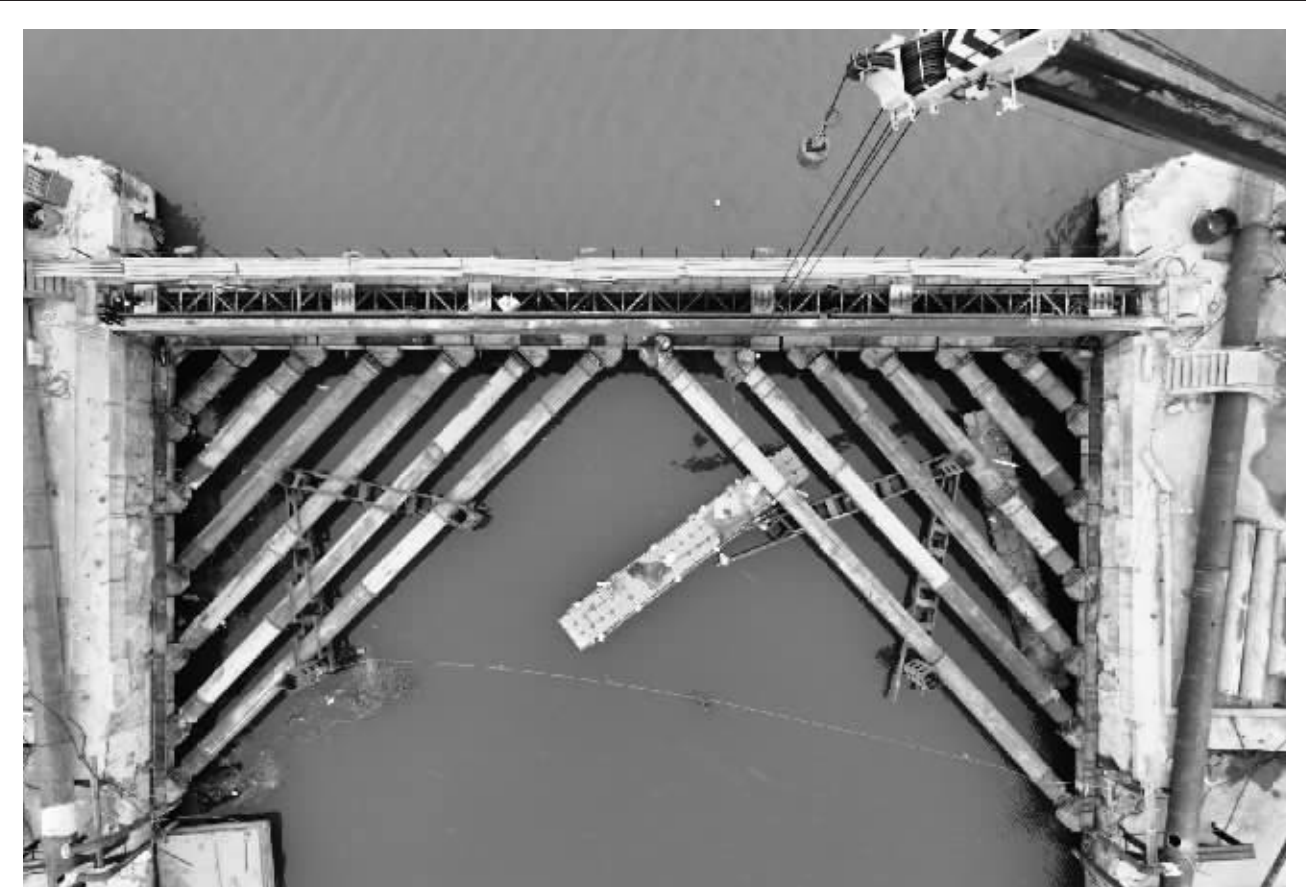
新春生产忙 抢抓“开门红” 2月6日,中交二航局工人在襄阳东西轴线鱼梁洲段焊接围堰。当日是大年初六,不少企业、施工单位争分夺秒开展生产,抢抓“开门红”。 新华社图文
