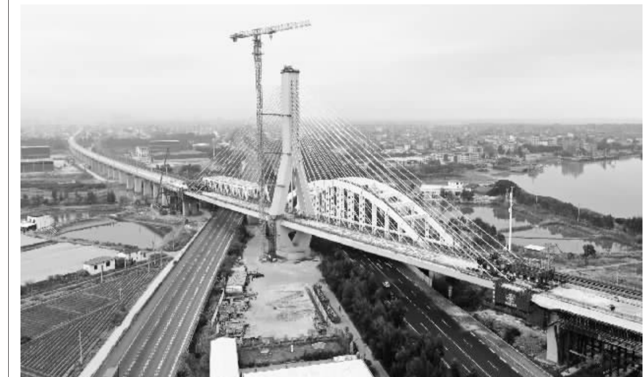
新建福厦铁路木兰溪特大桥斜拉桥主梁合龙 新建福厦铁路木兰溪特大桥斜拉桥主梁成功合龙。 1月16日,中国首条跨海高铁——新建福(州)厦(门)铁路木兰溪特大桥斜拉桥主梁顺利合龙。新建福厦铁路木兰溪特大桥位于福建省莆田市木兰溪河畔,全长约18.75公里,是全线重难点及控制性工程之一。 新华社图文
