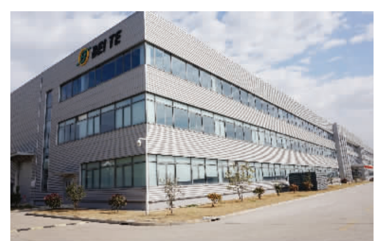
北特科技厂区
