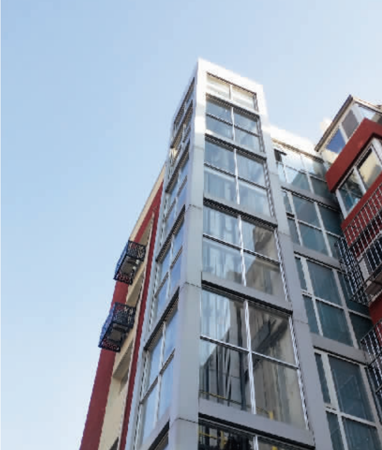
加装电梯后的北京工业大学四小区。
