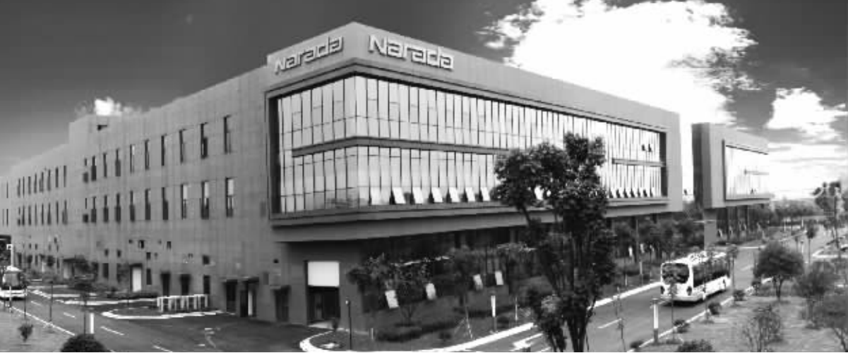
杭州南都电源动力科技有限公司一期建设项目
