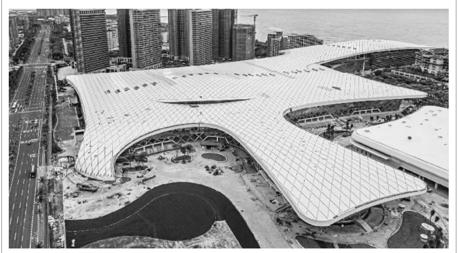
海南国际会展中心二期项目主体工程完工 这是8月25日拍摄的位于海口的海南国际会展中心二期项目。近期，位于海口的海南国际会展中心二期项目主体工程完工。目前项目正在进行收尾施工及系统运行调试。 新华社图文
