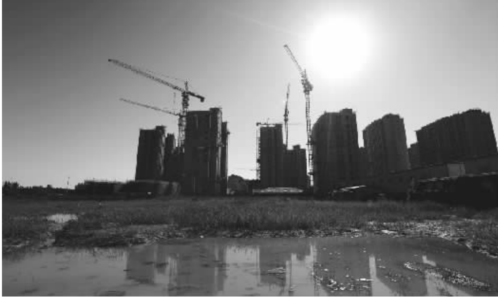
北京通州区一在建楼盘外景
