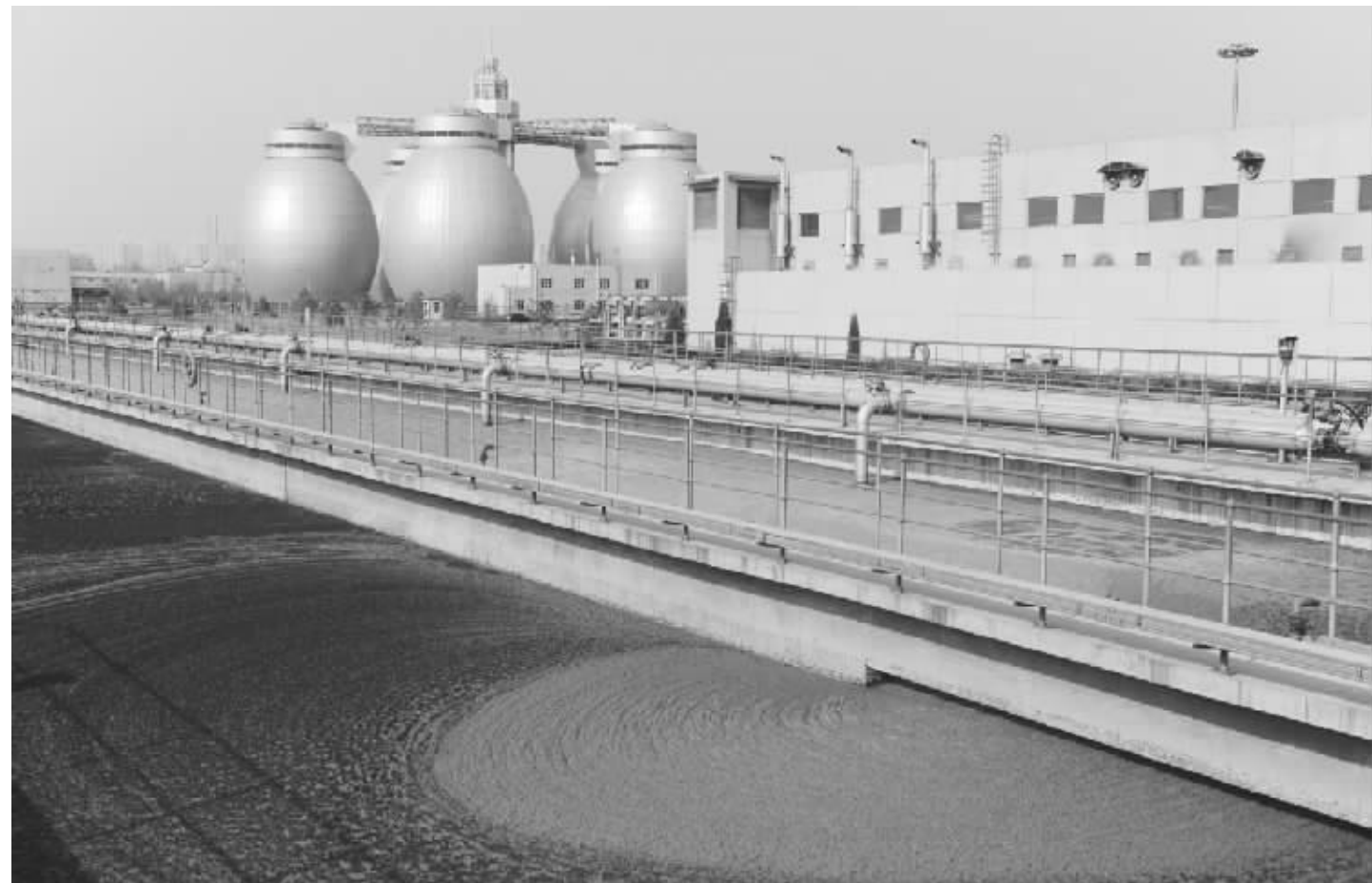
北京排水集团小红门污水处理厂,进入处理厂的污水在曝气池中进行污泥的初步处理。
