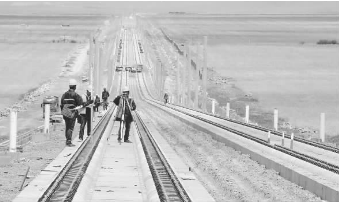
兰新铁路客运专线(甘青段)进入电气化施工阶段。7月28日,在青海省门源县境内的施工现场,技术人员在测量接触网支柱安装的基准数据。兰新铁路客运专线为国家Ⅰ级双线电气化铁路。该线建成后,将在甘肃、青海、新疆形成一条新的大能力快速铁路运输通道。
