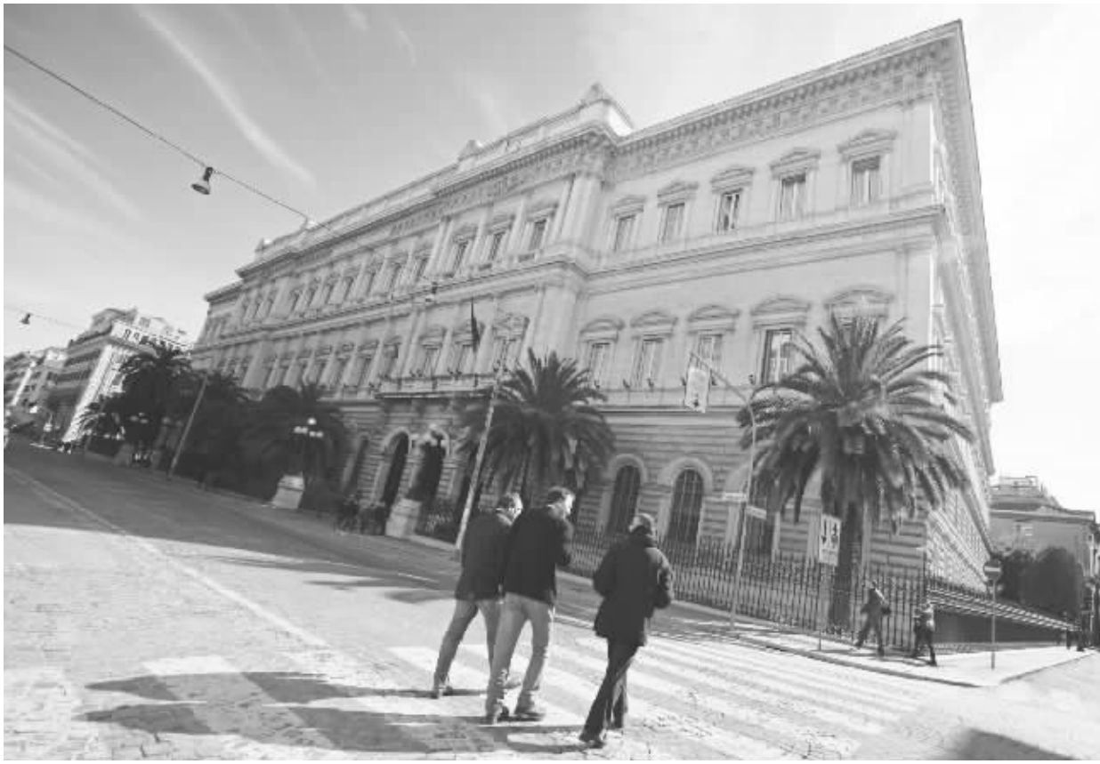
位于罗马的意大利央行总部大楼
