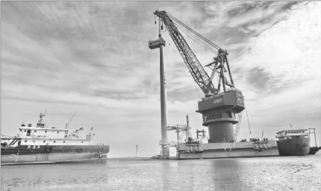
国电龙源江苏如东海上(潮间带)150MW示范风电场一期工程最后一台风机吊装现场。 CFP图片
