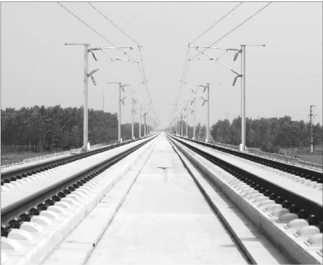
目前,石武高铁许昌段轨道铺设工程已全面完工,信号设备安装工作正在进行中。石(家庄)武(汉)高铁北起石家庄南站,南至武汉车站,正线全长840.7公里,与总长281公里的京石高铁相接,设计时速为350公里。这一连接北京和中部重镇武汉的高铁路客专专线开通后,北京—武汉的车程将由目前11个小时缩短到4小时左右。图为石武铁路客专专线许昌段铺设完工的轨道(5月5日摄)。
