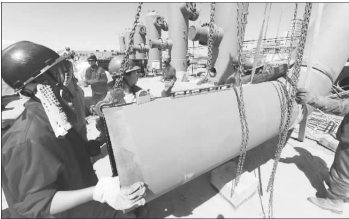
近日,西气东输二线霍尔果斯首站工程进度过半,两台30兆瓦的压缩机已安装到位,工程全面进入管线焊接和仪表调试、安装阶段。 新华社图片
