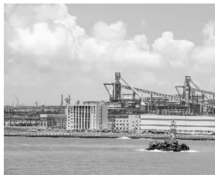
柳钢股份防城港钢铁基地
