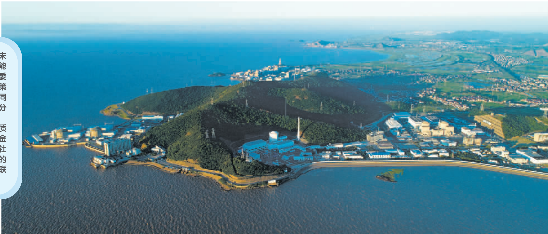
中国核电旗下泰山核电基地
