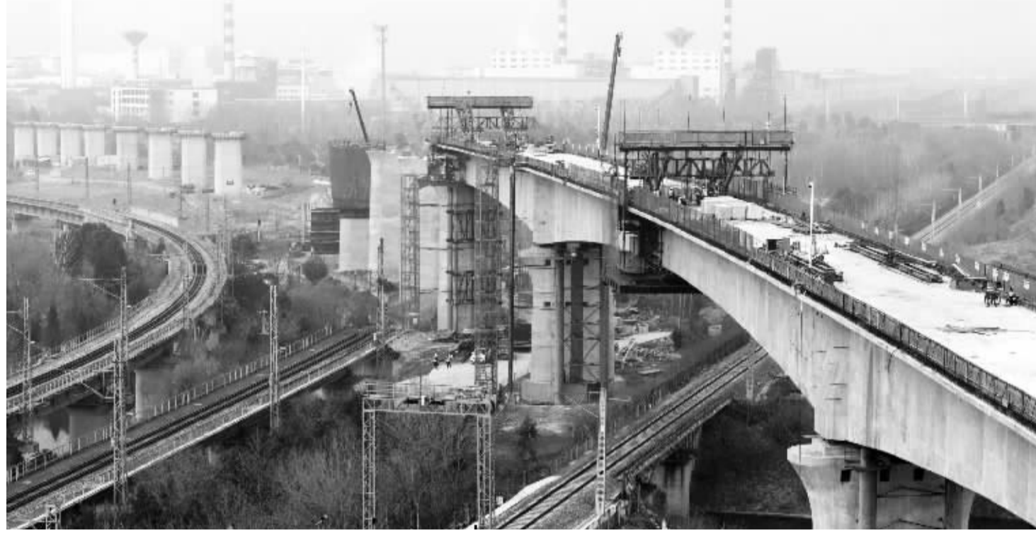
图为合新铁路跨既有铁路淮南下行线连续梁合龙施工现场(1月10日,无人机照片)。
