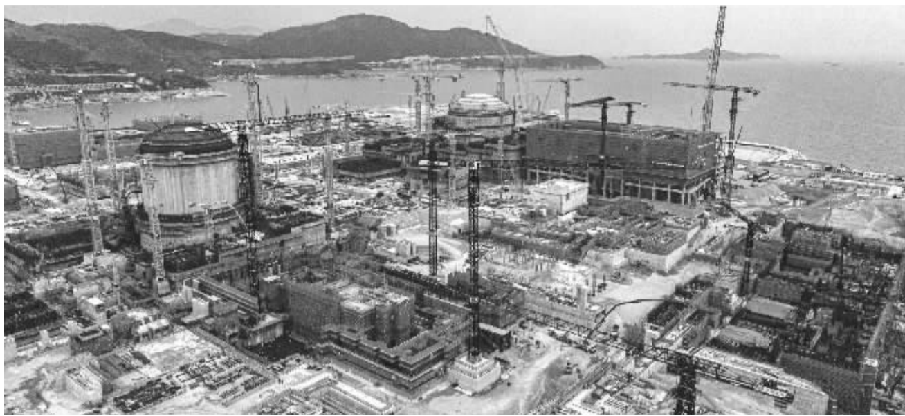
三澳核电项目建设现场
