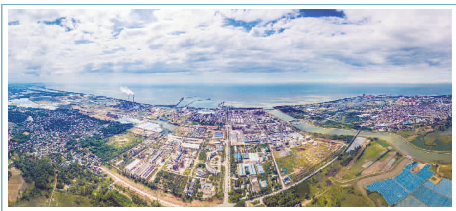
发展中的海南东方临港产业园(无人机全景照片,10月20日摄)。 新华社图文
