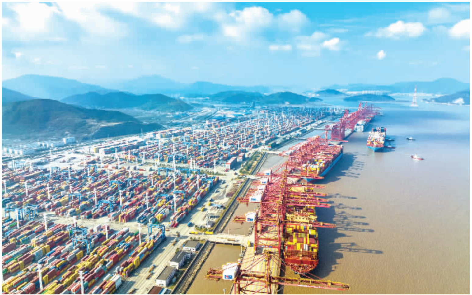
这是浙江宁波舟山港穿山港区 2021年12月24日摄，无人机照片。
