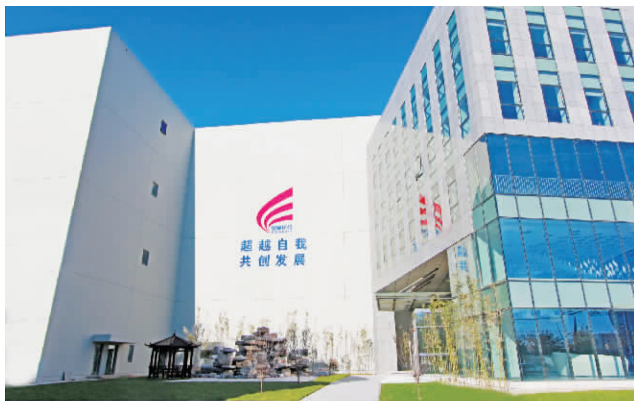
星昊医药-北京大兴基地冻干口崩车间
