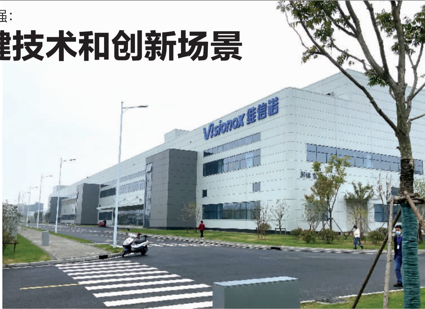
维信诺合肥第6代柔性AMOLED生产线总投资440亿元，设计产能为30K片/月。
