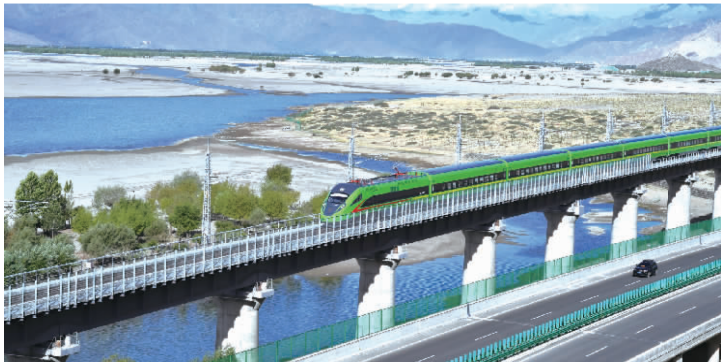
试运行的复兴号列车行驶在雅鲁藏布江畔。6月25日10时30分，一辆复兴号高原内电双源动车组缓缓驶出拉萨火车站，向林芝市进发。这标志着全长435公里、设计时速160公里的拉林铁路建成通车，西藏首条电气化铁路建成，同时复兴号实现对31个省区市全覆盖。新华社图文
