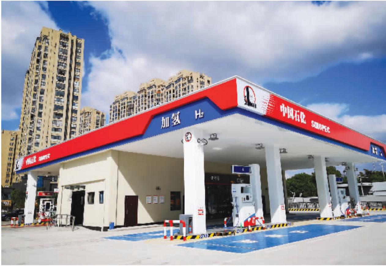
中国石化浙江嘉兴石油嘉善善通加油站，这是浙江省内首座集加油、加氢等功能于一体的综合能源供应站。 公司供图
