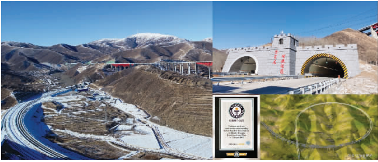
四川路桥建设的延崇高速金家庄特长螺旋隧道。
