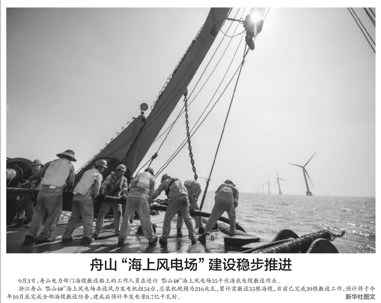
9月3日,舟山电力部门海缆敷设船上的工作人员在进行“岱山4#”海上风电场35千伏海底电缆敷设作业。浙江舟山“岱山4#”海上风电场共设风力发电机组54台,总装机规模为216兆瓦,累计需敷设55根海缆,目前已完成39根敷设工作,预计将于今年10月底完成全部海缆敷设任务,建成后预计年发电量8.7亿千瓦时。新华社图文
