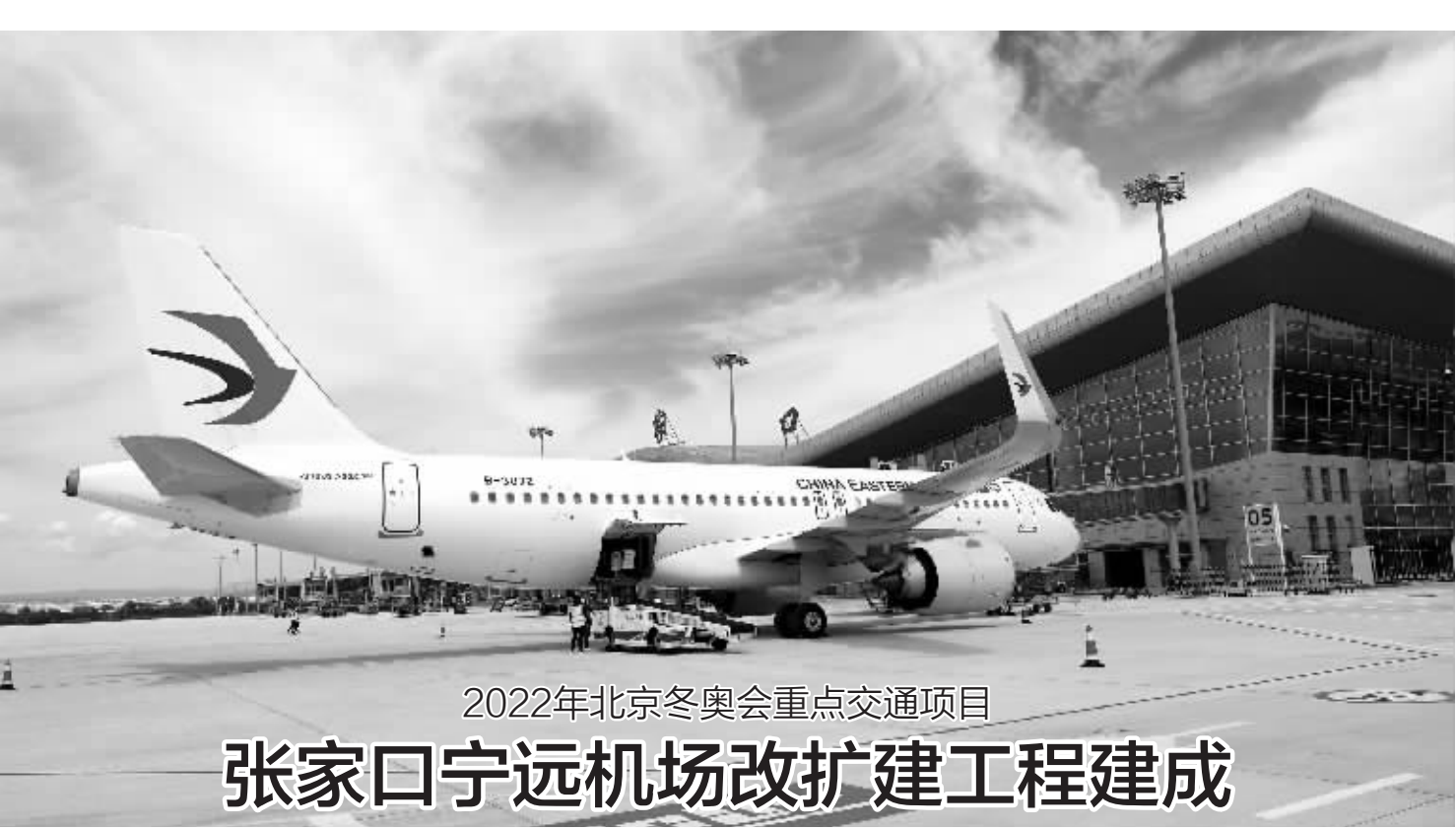
8月4日,工作人员在启用后的张家口宁远机场改扩建工程T2航站楼前停机坪上往客机上装运货物。近日,2022年北京冬奥会重点交通项目——张家口宁远机场改扩建工程正式建成并通航。张家口宁远机场改扩建工程主要包括建筑面积约2.8万平方米的新建航站楼、航管楼、应急救援中心等11栋单体建筑,以及新建停机坪、滑行道和跑道延长线等工程,总面积约20.5万平方米,工程总投资约13亿元。 新华社图文
