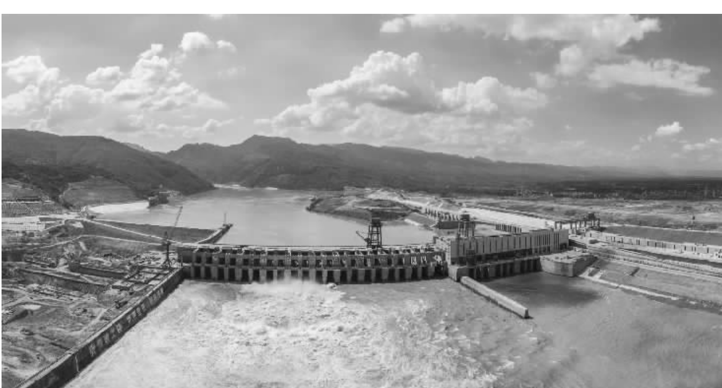
广西大藤峡水利枢纽工程建设进展顺利 目前,广西大藤峡水利枢纽工程建设进展顺利,其中工程左岸厂坝、船闸等建设项目已初步建成并投入使用,右岸坝体等正在紧张建设中。图为建设中的广西大藤峡水利枢纽工程。 新华社图文
