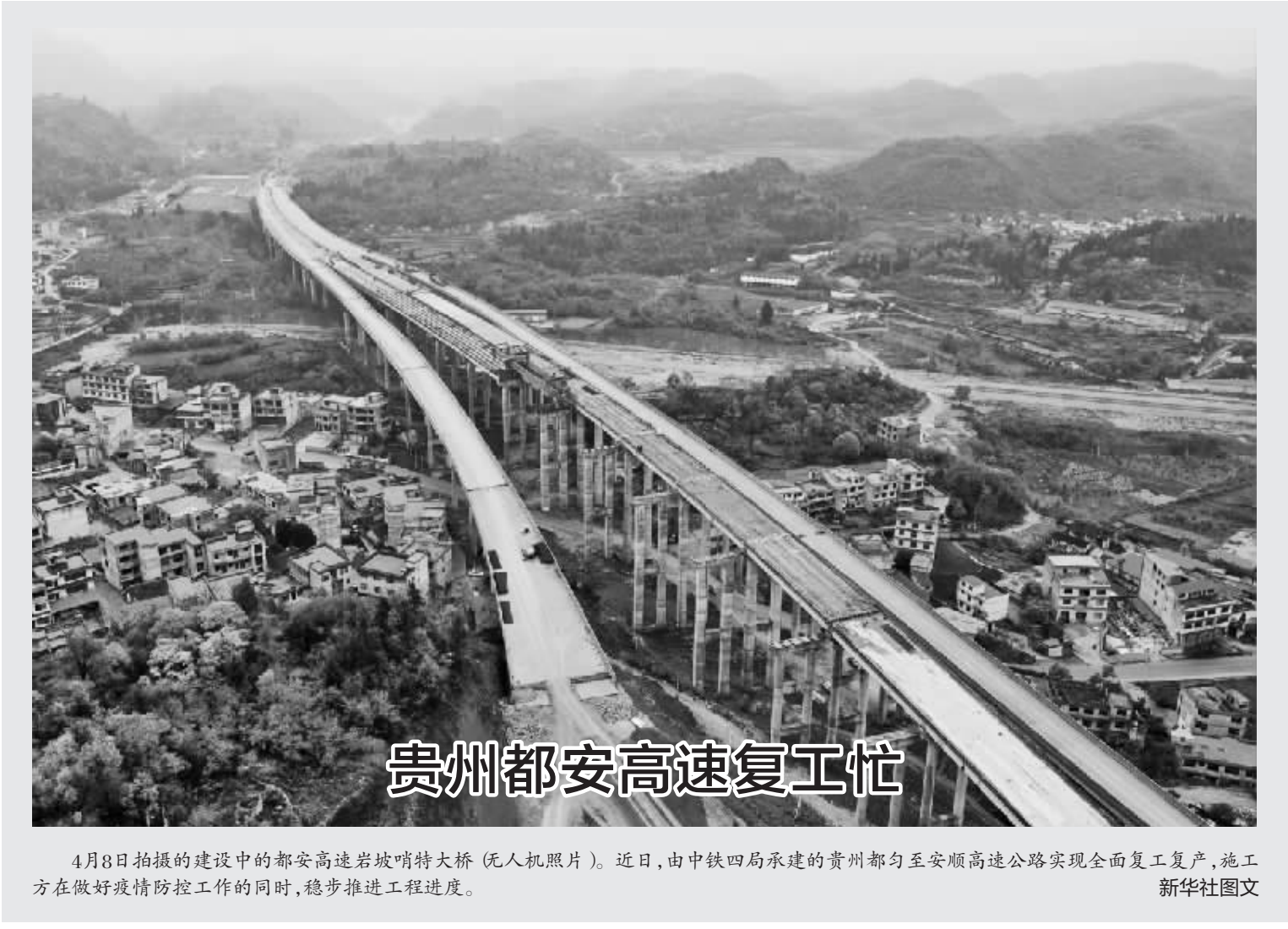
4月8日拍摄的建设中的都安高速岩坡哨特大桥(无人机照片)。近日,由中铁四局承建的贵州都匀至安顺高速公路实现全面复工复产,施工方在做好疫情防控工作的同时,稳步推进工程进度。 新华社图文
