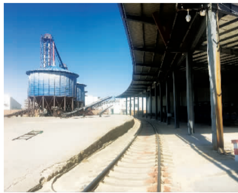
元润粮油粮仓及火车运输轨道
