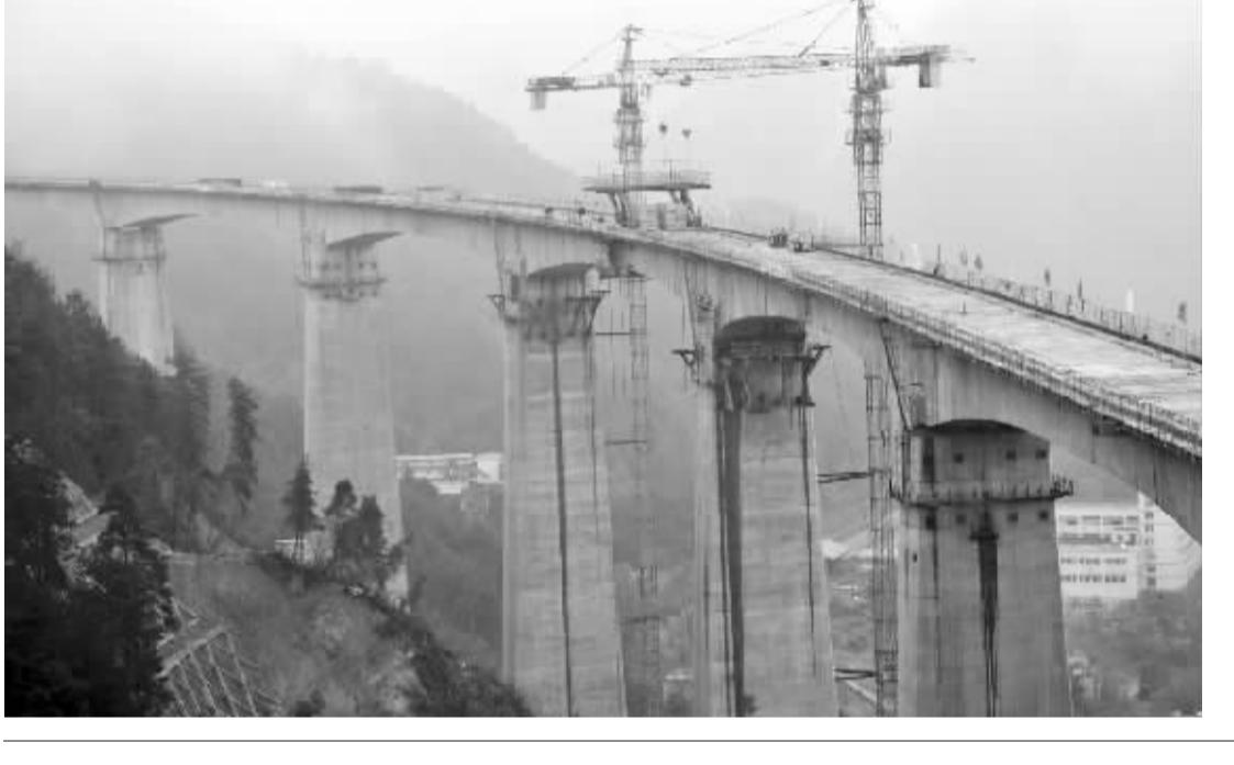
12月10日拍摄的正在进行混凝土浇筑施工建设的贵广铁路引入线圣泉一号双线特大桥。当日,贵广(阳)广(州)铁路客运专线圣泉1号双线特大桥连续梁顺利浇筑完成,比节点工期提前50天完成合拢。
